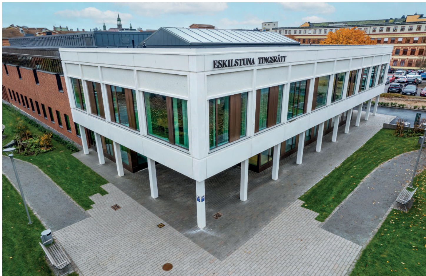
Valören 1, Eskilstuna tingsrätt
